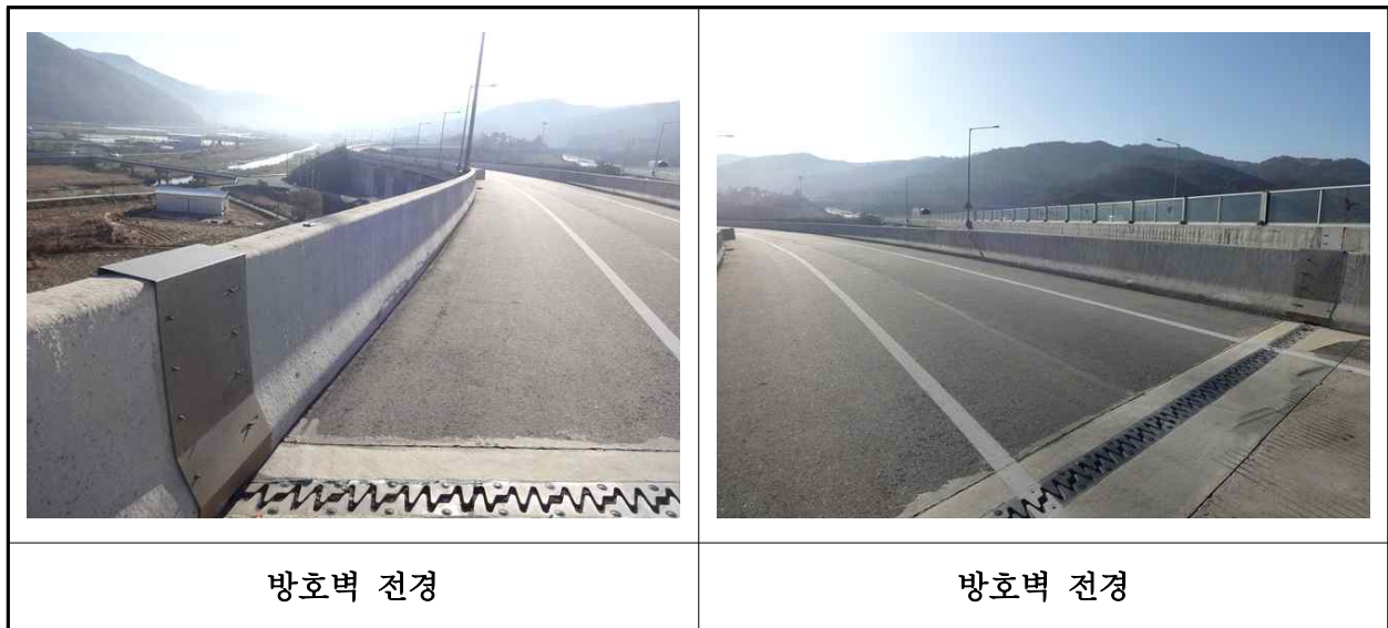
【사진 16.3.23】 방호벽 및 중앙분리대 전경
