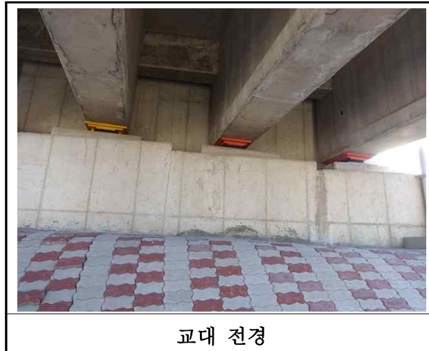
【사진 16.3.8】 교대 전경
