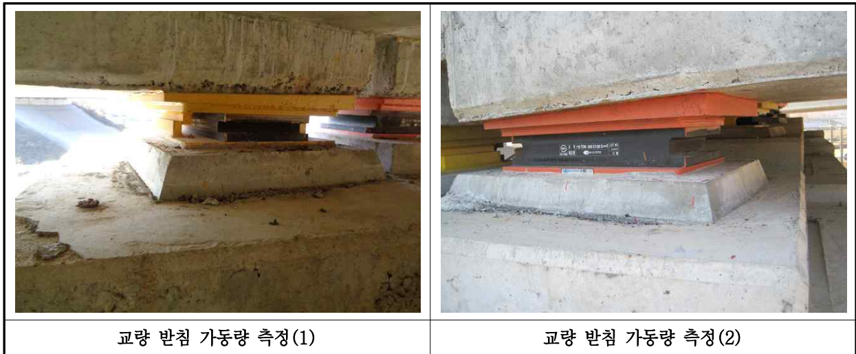
【사진 16.3.15】 교량받침 이동량 측정
