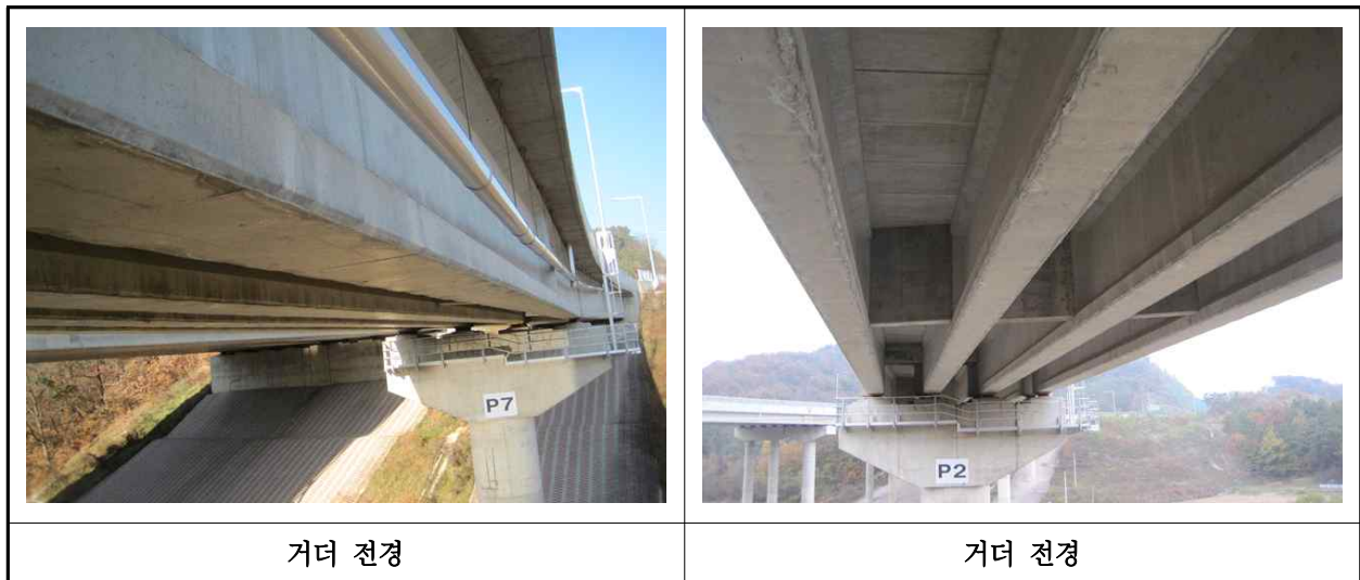
【사진 16.3.4】 거더 전경
