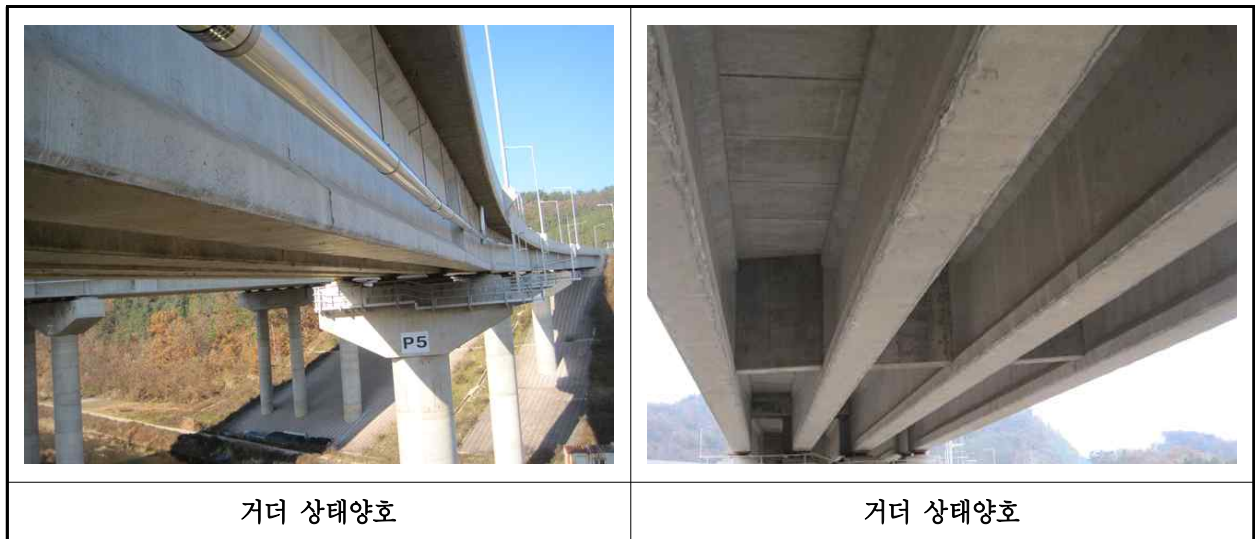
【사진 16.3.5】 거더 손상현황
