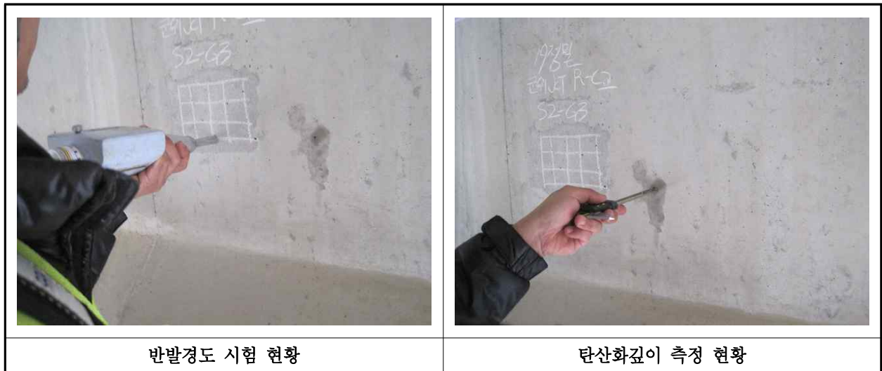
【사진 16.4.1】 콘크리트 내구성조사 현황
