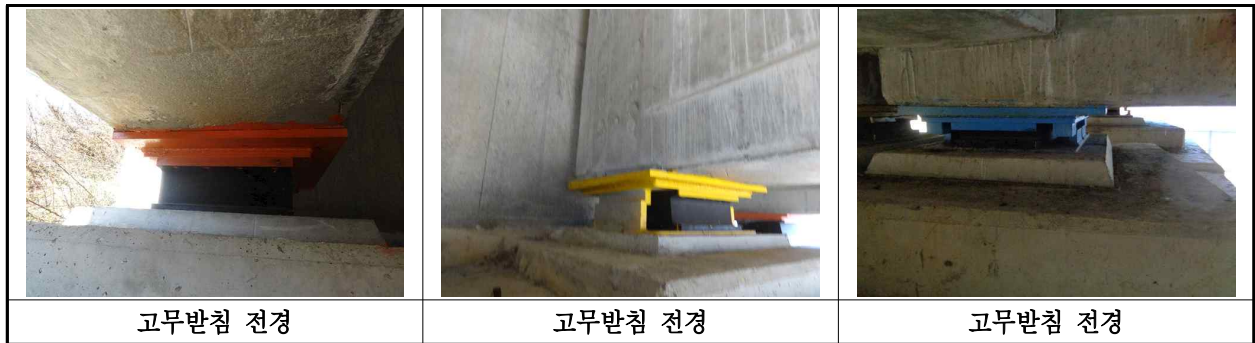
【사진 16.3.12】 교량반침 전경
